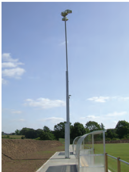
15 м телескопические мачты на футбольном стадионе Стоун Домино в Англии. В данном районе допускается максимальная высота 8 м.
